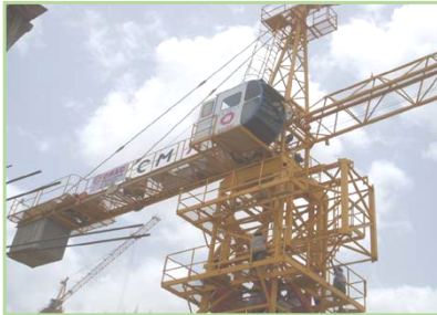
Maquinaria de Construcción
