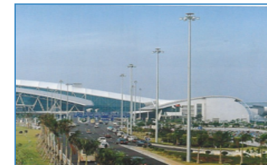
Postes de Acero
